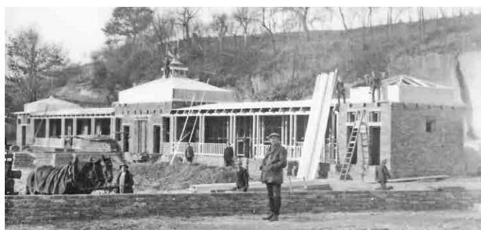
Stavba trvala necelý rok. Řídil ji stavitel J. Oborský. Foto: archiv J. Říhy 4x
