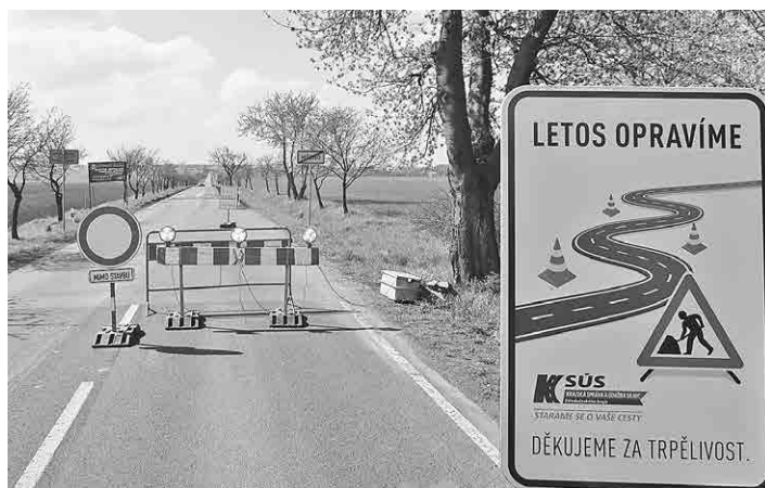
Stavbaři pracují na prvním úseku ze Mšena ke Kanině. Foto: M. Bauer 2x
