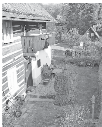
Opravený mlýn. Foto: Z. Bergl 4x
