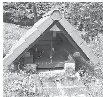
Pramen na louce v Konrádově.
