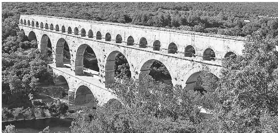
Pohled na jižní stranu mostu Pond du Gard z vyhlídky na stráni. Foto: Z. B. 3x
