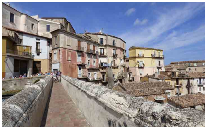
Corigliano Calabro. Středověký akvadukt dnes slouží jako most.
