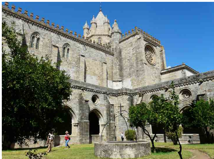
Křížová chodba pod katedrálou Santa Maria.
