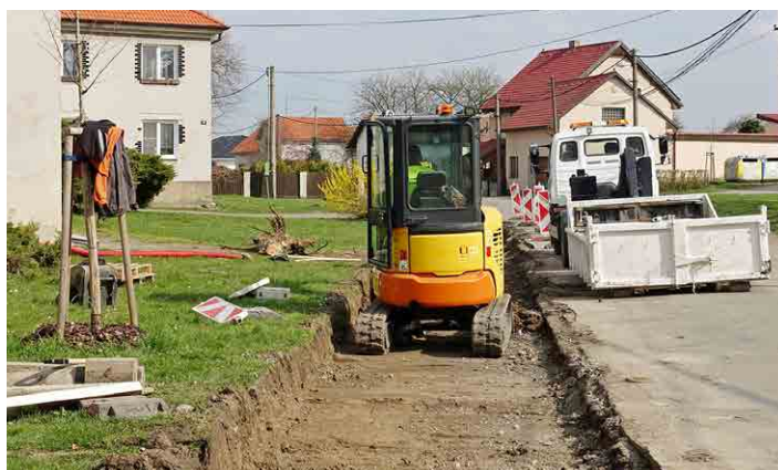
Stavba v centru Chorušic má stát přes 10 milionů korun. Foto: J. Havel 2x
