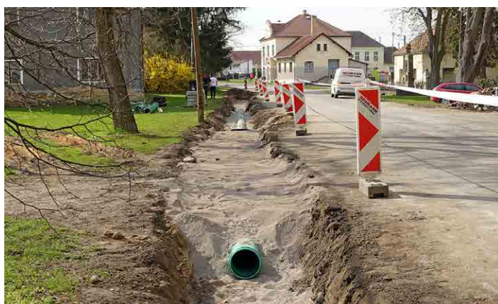
Stavební práce mají trvat nejpozději do konce letošního září.
