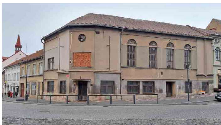
Zanedbaná budova vyvolává ve Mšeně rozpory. Foto: Jiří Říha
