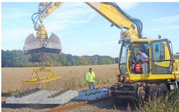
Na opravě trati pracuje množství těžké techniky. Foto 2x: Karel Horňák
