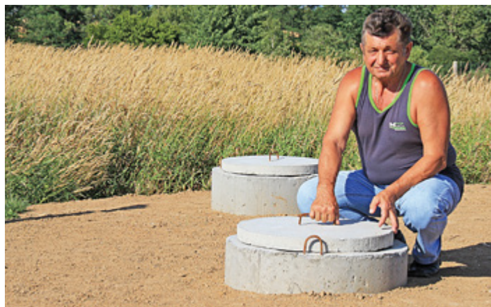
U kořenovky nechala obec vybudovat odkalovací zařízení. Foto: J. Říha
