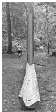
Nová modřínová noha s ocelovým jádrem, usazení konstrukce i návrat klobouku na své místo. Foto: Jiří Říha 4x
