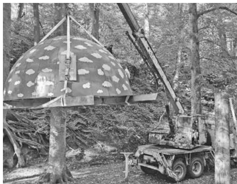
Nová modřínová noha s ocelovým jádrem, usazení konstrukce i návrat klobouku na své místo. Foto: Jiří Říha 4x
