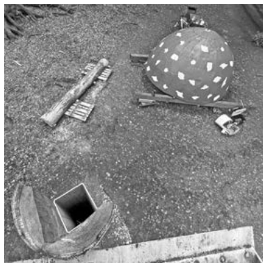
Nová modřínová noha s ocelovým jádrem, usazení konstrukce i návrat klobouku na své místo. Foto: Jiří Říha 4x
