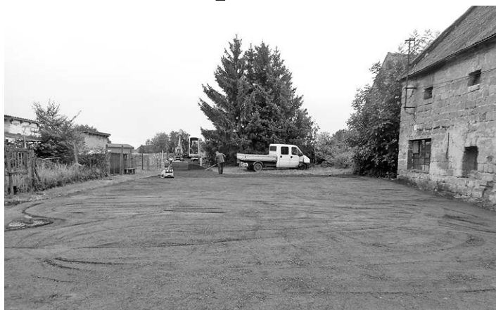
Mezi požadavky kolaudace nových bytů patří i parkoviště. Foto: Š. D.
