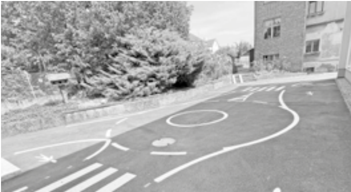
V areálu mateřské školy došlo k obnově asfaltových povrchů.
