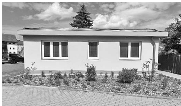
Komunitní centrum vzniklo přestavbou staré lékárny. Foto: J. Guttenberg
