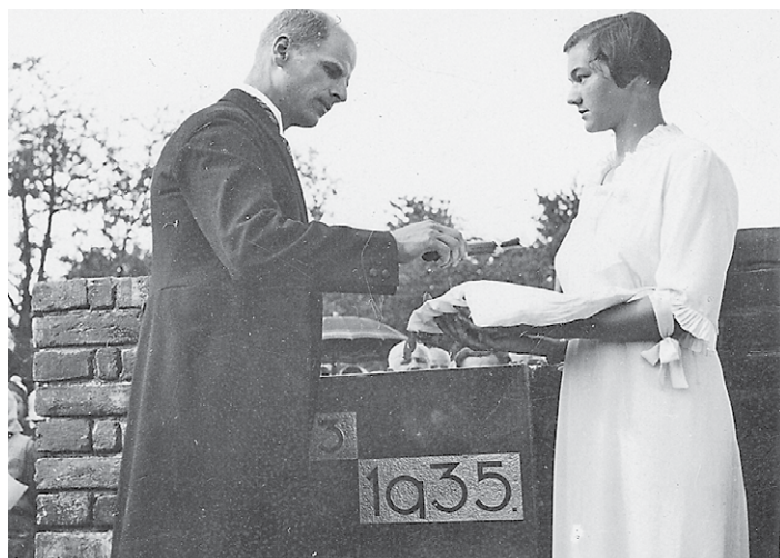
Libuše při pokládání základního kamene ev. kostela ve Mšeně.
