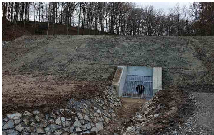
Ve Skramouši byl vybudován takzvaný suchý poldr. Foto: Josef Havel
