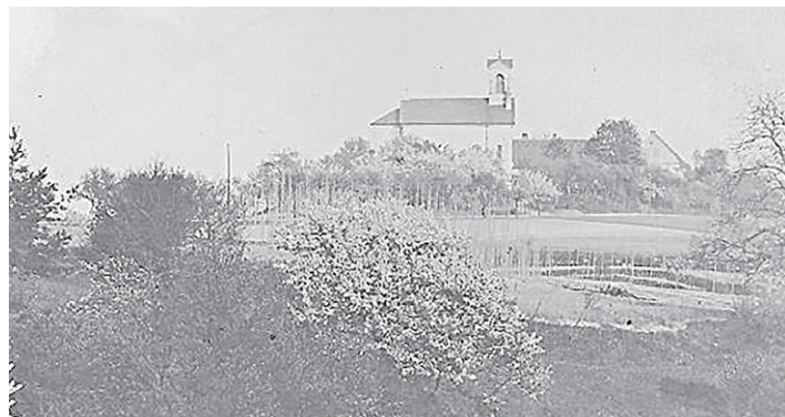
Kaple na fotografii ze začátku dvacátého století. Foto: archiv J. Říhy
